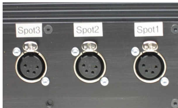
Sorties pour connecter les panneaux lumineux
